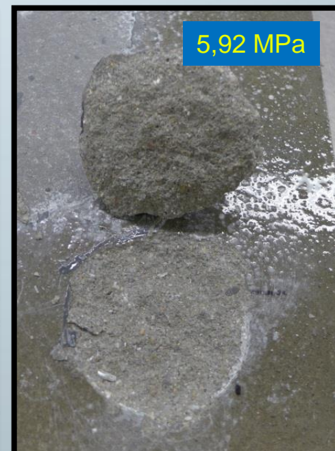
epoxidový podlahový lak + ETERNAL lak na beton
